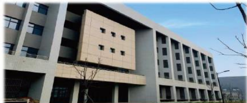
空天动力综合楼：9,950m 2
